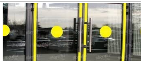
Fig. V.23. – Exemplu de conformare a suprafețelor vitrate în cadrul foi de ușă și realizarea contrastului vizual
