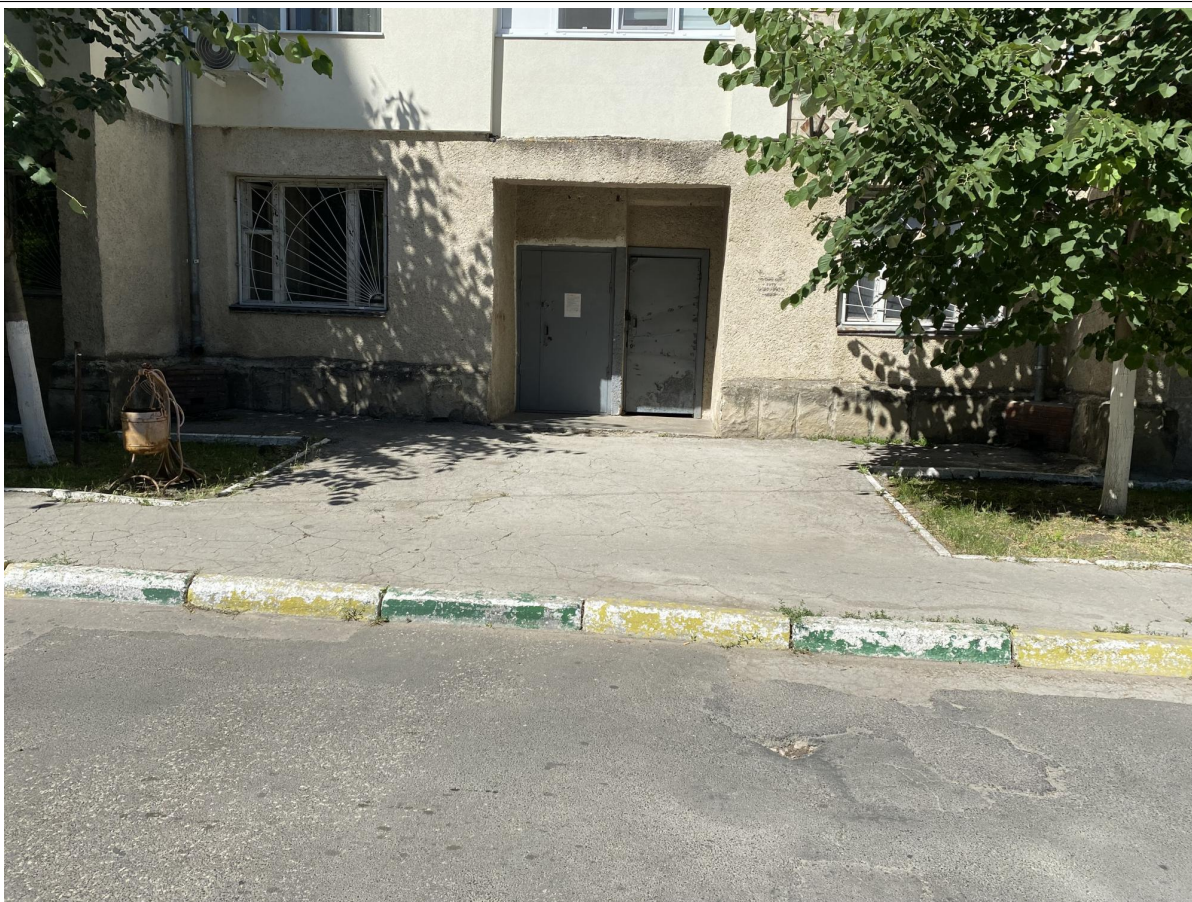
Galerie - Căi de acces către clădire
