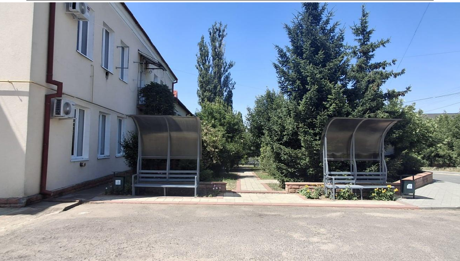
Galerie - Căi de acces către clădire
