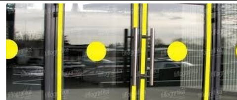
Fig. V.23. - Exemple de conformare a suprafețelor vitrate în cadrul foii de ușă și realizarea contrastului vizual
