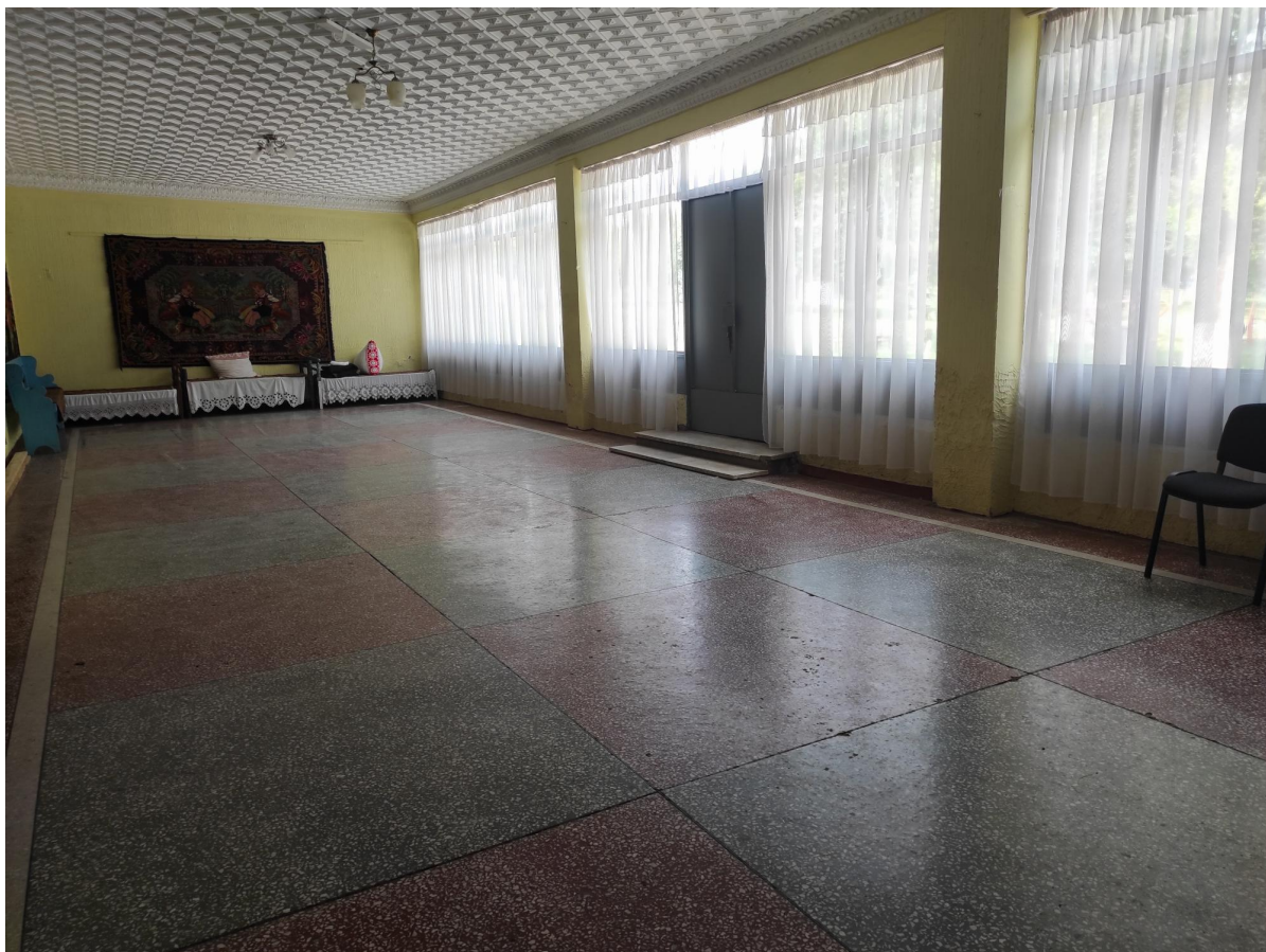
Galerie - Grup sanitar
