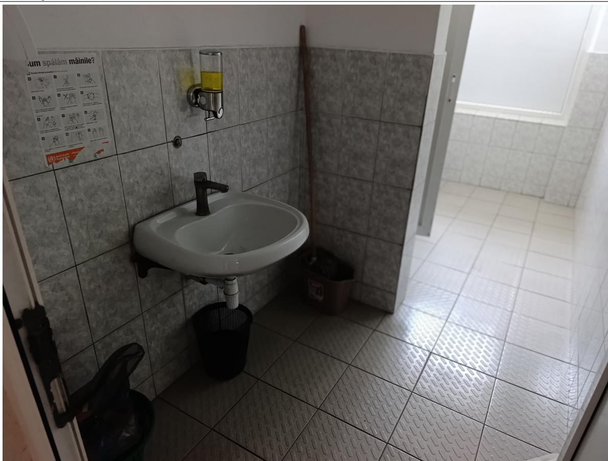
Galerie - Grup sanitar
