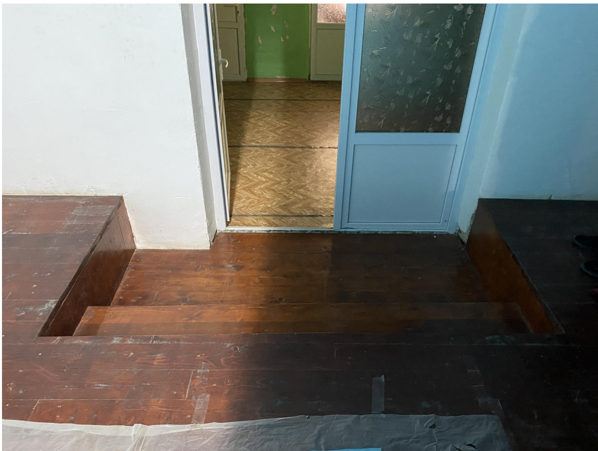
Galerie - Grup sanitar
