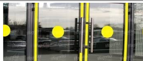
Fig. V.23. – Exemplu de conformare a suprafeţelor vitrate în cadrul foi de uşă şi realizarea contrastului vizual
