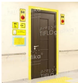
Fig. V.23. - Exemplu de conformare a suprafețelor vitrate în cadrul foilor de ușă și realizarea contrastului vizual
