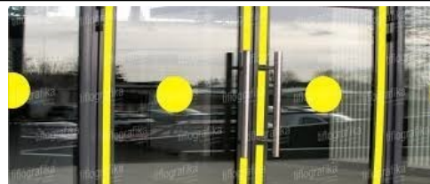
Fig. V.23. - Exemplu de conformare a suprafețelor vitrate în cadrul foilor de ușă și realizarea contrastului vizual
