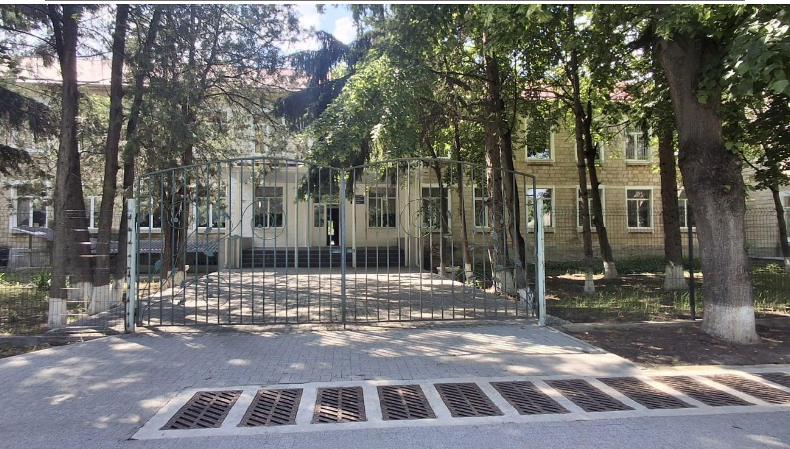
Galerie - Căi de acces către clădire
