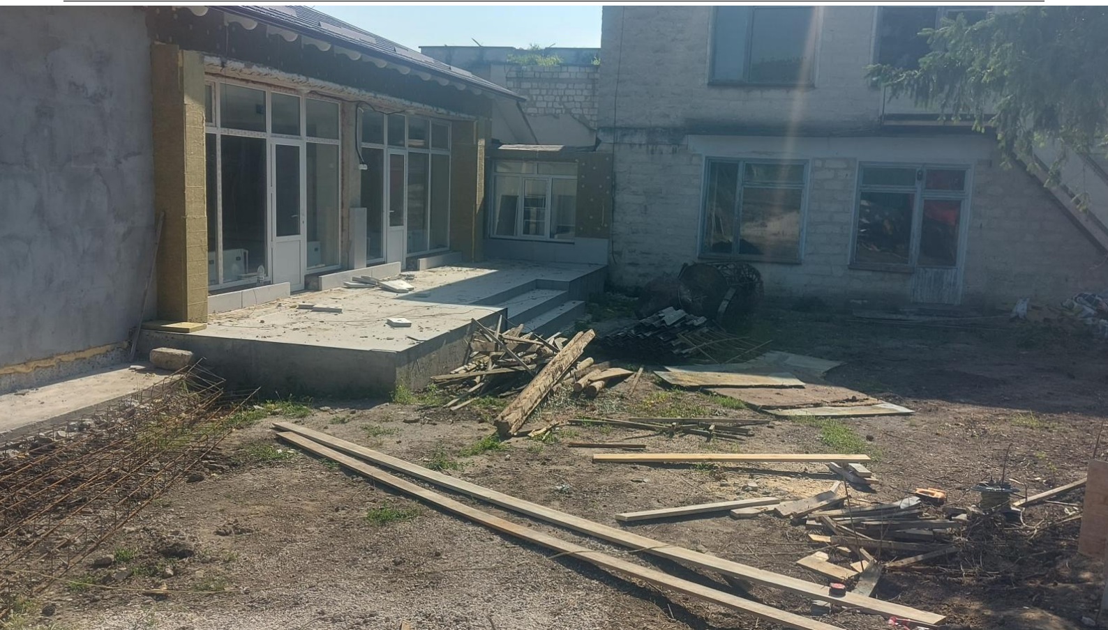
Galerie - Căi de acces către clădire
