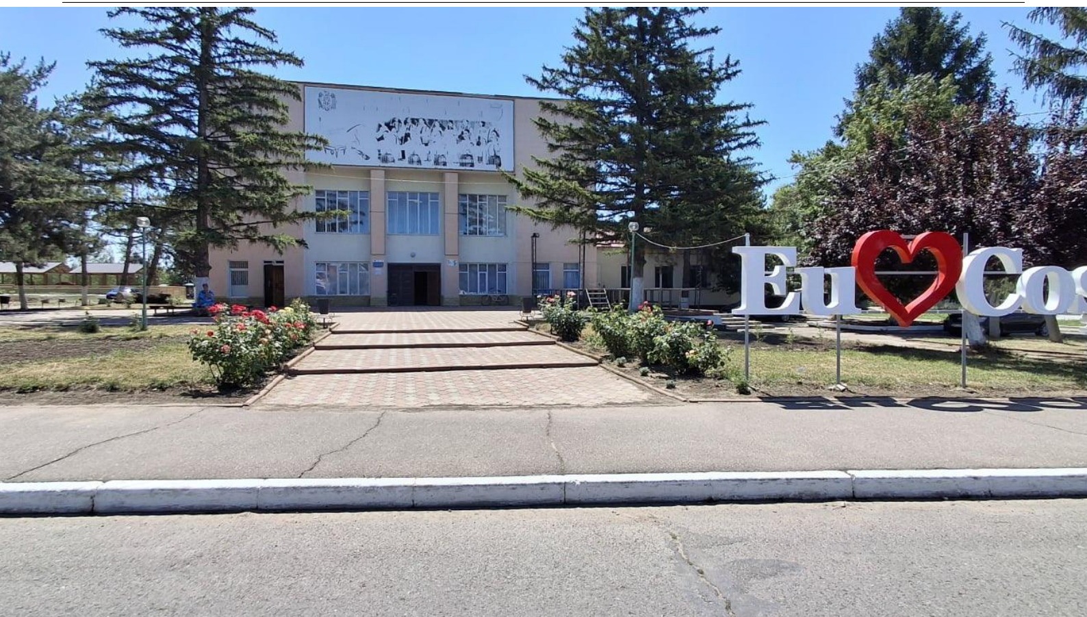
Galerie - Căi de acces către clădire
