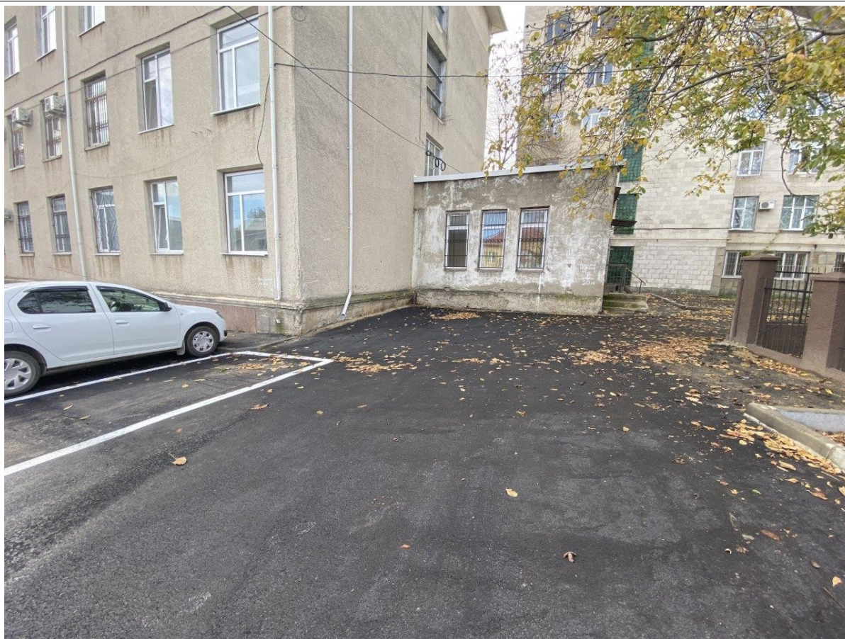
Galerie - Căi de acces către clădire
