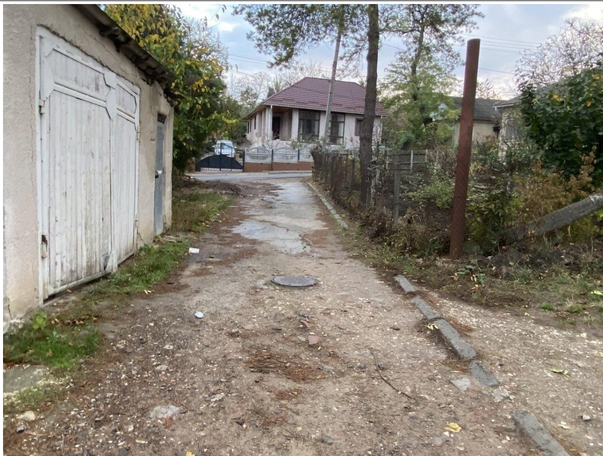
Galerie - Căi de acces către clădire
