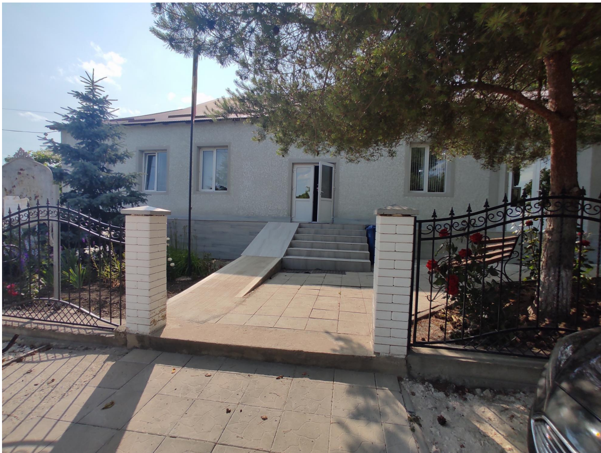
Galerie - Căi de acces către clădire
