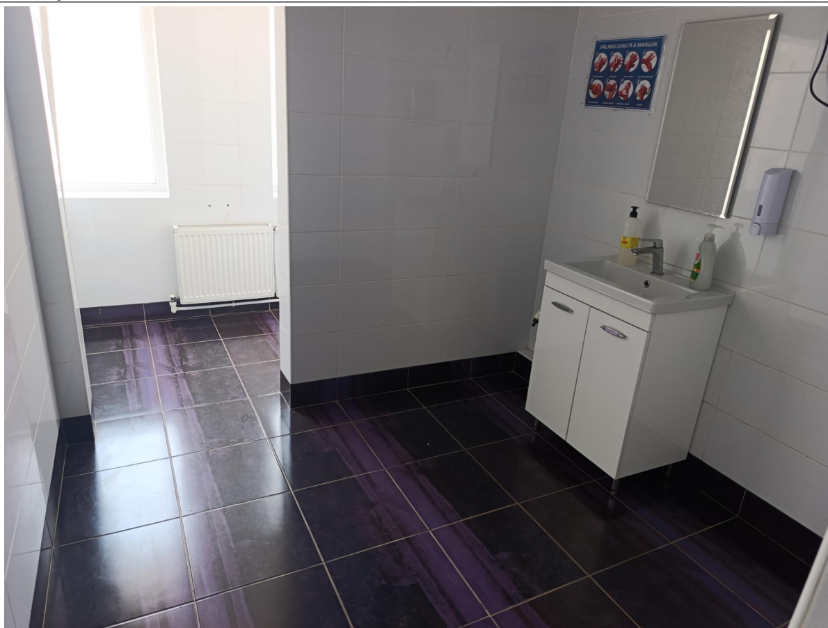
Galerie - Grup sanitar
