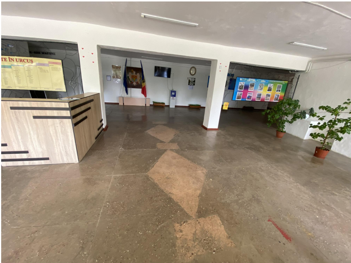
Galerie - Grup sanitar
