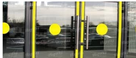
Fig. V.23. – Exemplu de conformare a suprafețelor vitrate în cadrul foii de ușă și realizarea contrastului vizual
