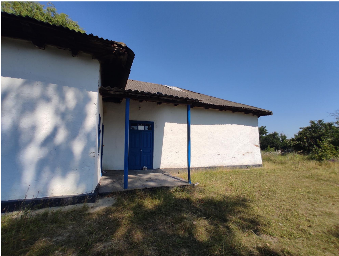
Galerie - Căi de acces către clădire
