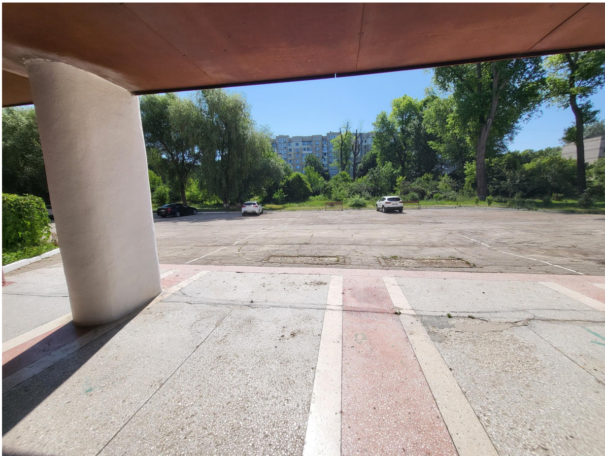
Galerie - Căi de acces către clădire
